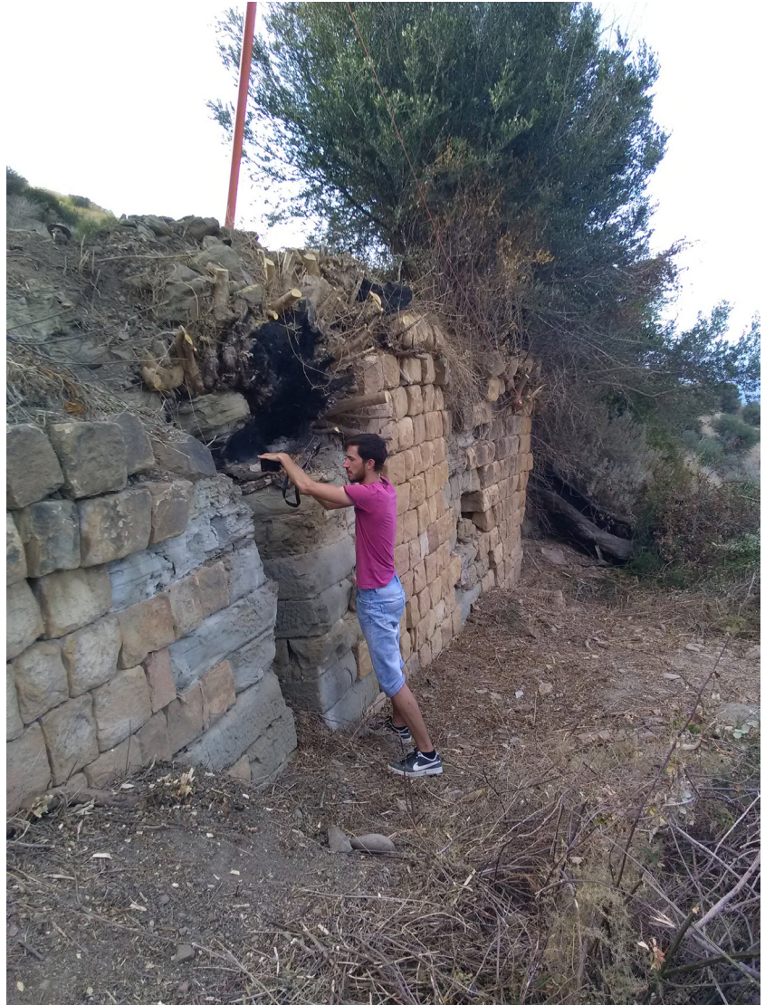
Figura 18 : Relievo fotogrammetrico delle mura di cinta a destra del settore di studio © MAFHA / Frédéric Gerber
