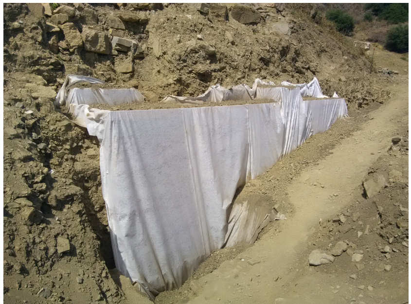
Figure 130 : Le mur de parodos totalement recouvert de géotextile et de terre. © Frédéric Gerber, MAFHA 2021.
