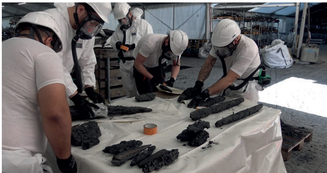
Le chantier de Notre-Dame, 22 septembre 2020 : la fabrication de « berceaux » pour transporter les vestiges de la charpente calcinée.
